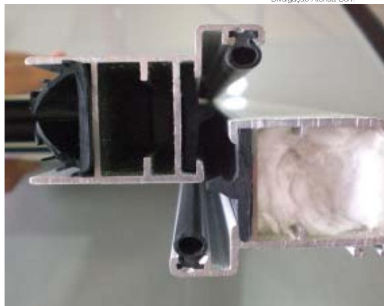
Perfil acústico: imagem mostra as vedações e o preenchimento do insumo
