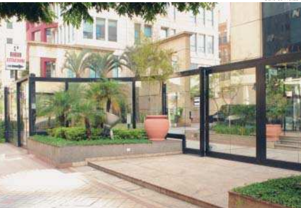
Outro edifício na Avenida Angélica
